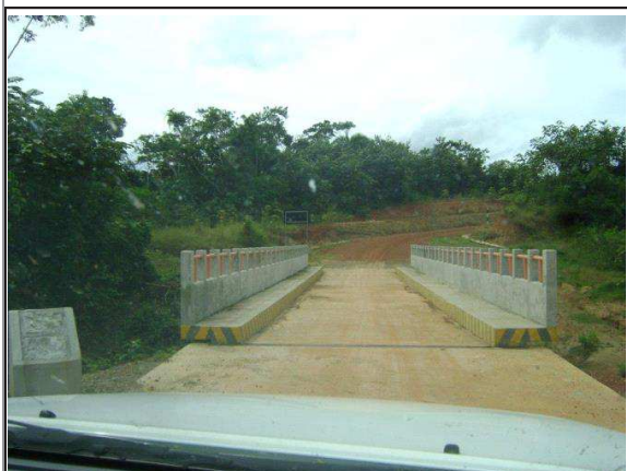
Foto 05: Puente de Concreto, en servicio. Con Plataforma, Veredas y Barandales en buen estado operativo.
